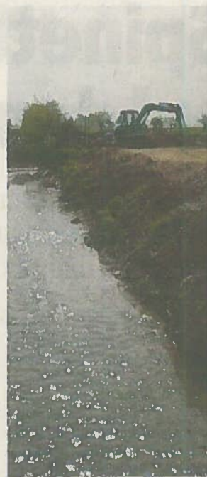
Lavori lungo il Lovassina
